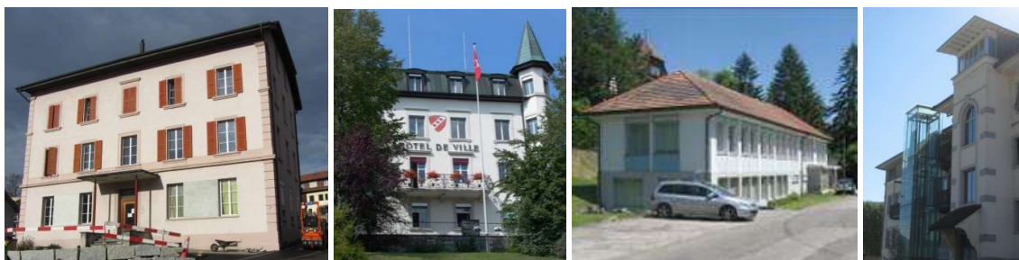
III. IV.4 à IV.7 : Ecole devenue logements à Reconvilier ( III. IV.4 ) et usines devenues Hôtel de Ville ( III. IV.5 ) ou bureau d'ingénieurs à Tramelan ( III. IV.6 ) et logements à Cortébert ( III. IV.7 )
