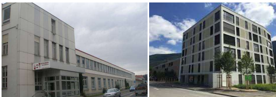
III. IV.2 et IV.3 : L'opération peut-être la plus emblématique de ces dernières années dans l'AaJb avec la déconstruction du site Schäublin ( III. IV.2 ) et la reconstruction de l'opération 'Espace Birse' ( III. IV.3 )
