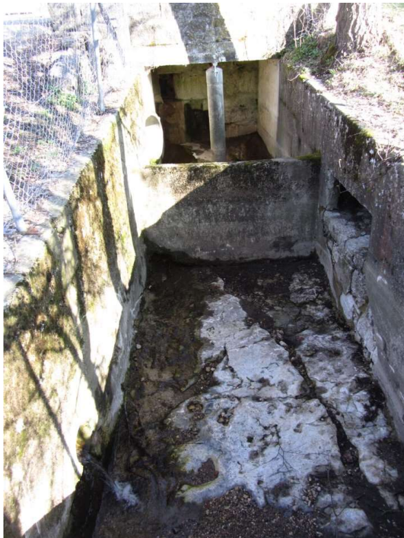
Ouvrage derrière la Fontaine dans lequel s'écoule l'eau de celle-ci + diverses canalisations d'eaux claires ( la Fontaine est alimentée par la source de la Titche )
