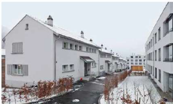
Les généreux espaces extérieurs de l'ensemble d'habitat ouvrier des années 1940 sont conservés, les nouveaux immeubles d'habitations sont construits en bordure de la parcelle et réduisent la pression sur l'existant. Ensemble d'habitat ouvrier Turmmatt, Altdorf UR, 2009, HTSA architectes
