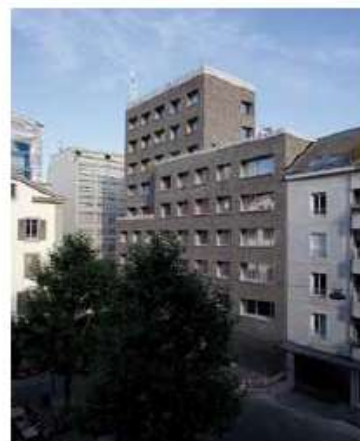
Un bâtiment de logements pour étudiants vient s'implanter sur une parcelle résiduelle située au centre-ville. Genève, 2011, Charles Pictet Architecte
