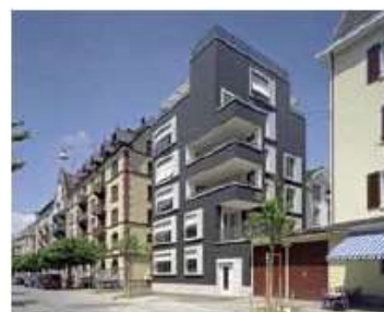
Cet immeuble d'habitation complète le tissu urbain en s'implantant sur une minuscule parcelle libre et en s'accrochant contre un bâtiment existant. Les quatre appartements s'étendent sur l'ancien et le nouveau bâti. Immeuble d'habitation Zurlindenstrasse, Zurich, 2004-2006, Huggenberger Fries Architectes
